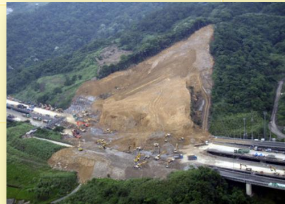
2010年4月25日國道3號 約3.1公里處發生嚴重走山崩塌
