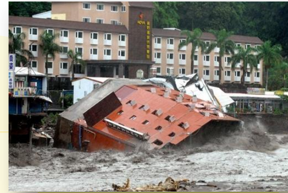
2009年莫拉克颱風 臺東金帥飯店倒塌
