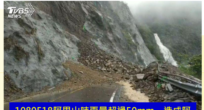
1080518阿里山時雨量超過50mm，造成阿里山公路78.3k邊坡坍方，雙向交通中斷
